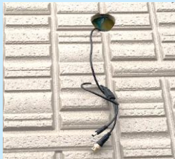
壁の内側に配線
