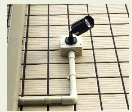
VE配管取付設置例
