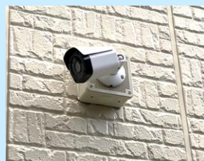
端子BOXの上にカメラ取付
