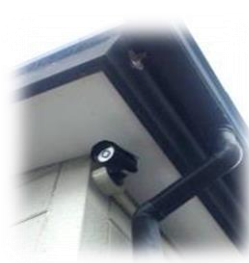
軒下(他方向) 設置
